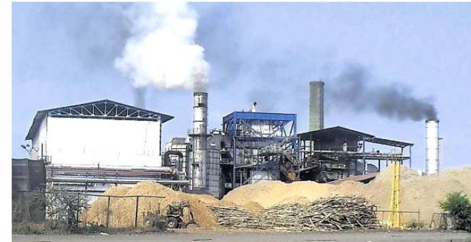
Hier ist ein Teil der Produktionsanlage für Bioethanol zu sehen.
