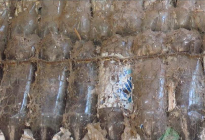
worden. Die Flaschen wurden dabei ineinander gesteckt, mit Draht befestigt und dann mit Mörtel zu tragenden Wänden verputzt. Die Schönheit des Recyclings präsentieren dabei die aus Buntglasflaschen bestehenden Fenster, die das Innere des Gebäudes in ein fast sakrales Dämmerlicht tauchen.
